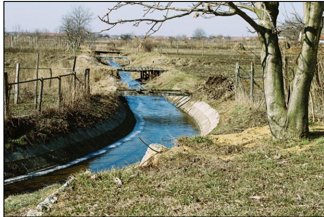
1. kép: Károlyi Főfolyás
